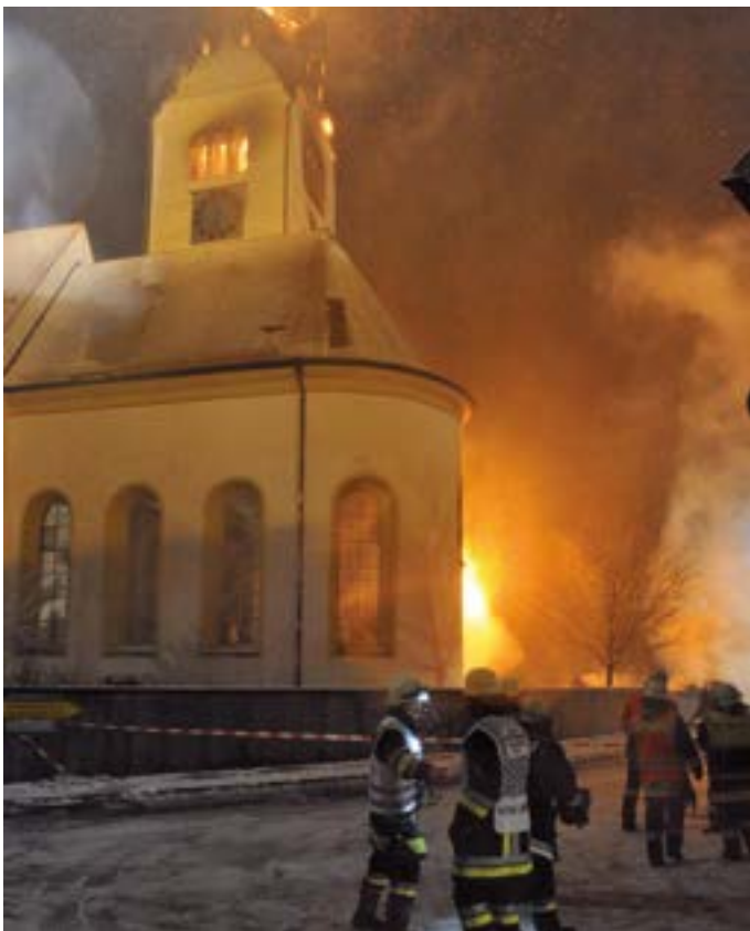
Incendio en la torre de una iglesia por impacto de rayo. Wald (Alemania).
