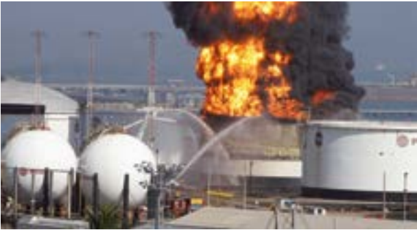
Incendio en refinería por caída de rayo. Puerto Cabello (Venezuela).
