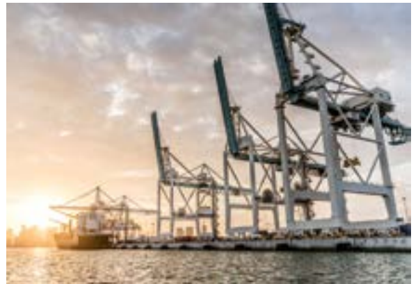
Cualquier instalación o maquinaria utilizada para el trabajo
